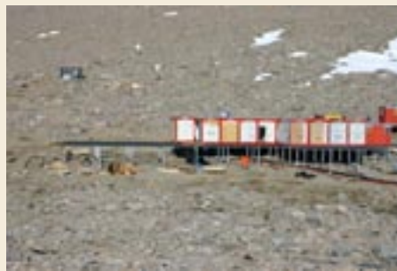
Helårsstasjonen under bygging 12. januar 2005
